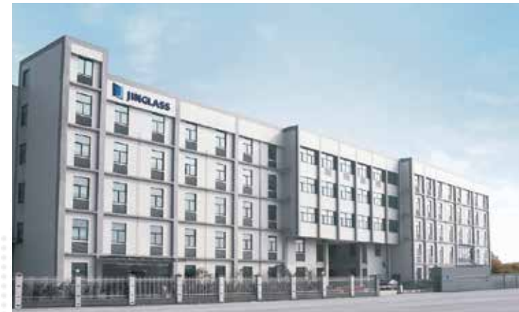
Hangzhou Production Base 杭州生产基地
